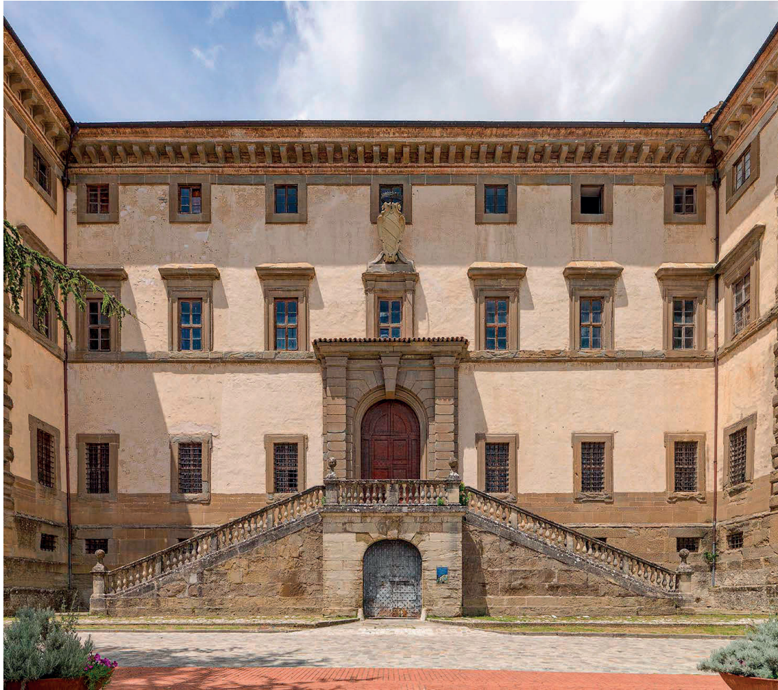
Facciata principale del palazzo di Carpegna
